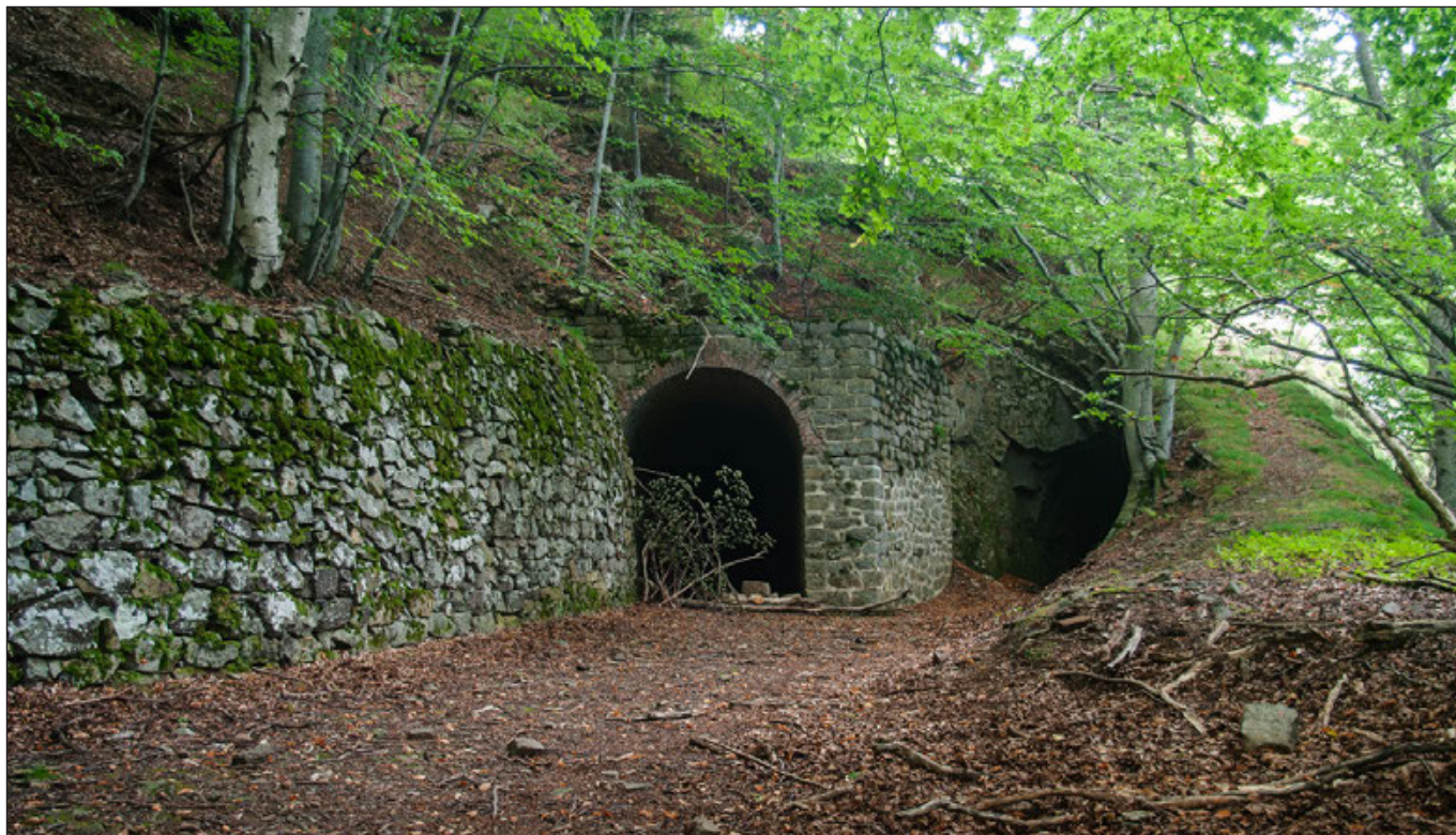
Fig. 13 : Sortie orientale du tunnel principal de Repalona — Sortida oriental del túnel principal de Repalona. Photo : R. Molina, 2019 / SMC GS
